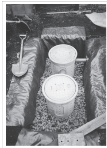
写真一3 雨水浸透柵 (例)
